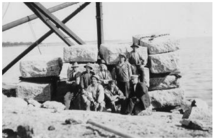
Bild från kajen där blocken ligger och väntar på utlastning.
