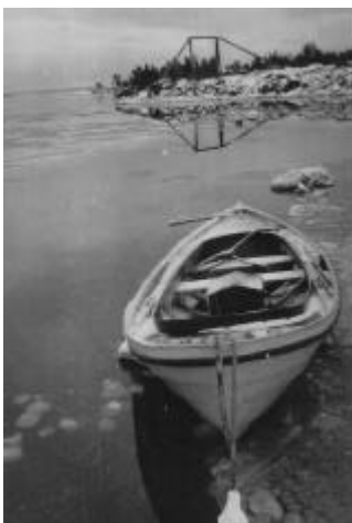
Bild från nordost. Utlastningskajen och kranen i bakgrunden
